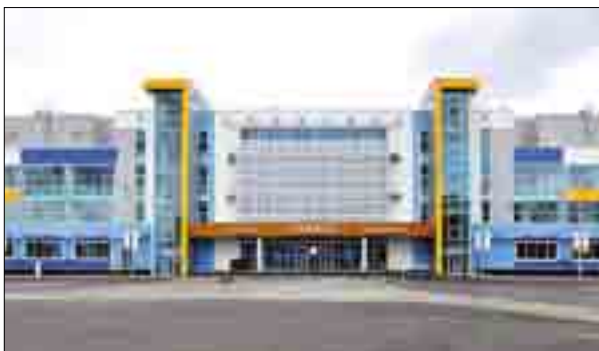
11 НОВЫХ СПОРТИВНЫХ КОМПЛЕКСОВ ПЕРЕДАЮТСЯ ВУЗАМ КАЗАНИ. СРЕДИ НИХ ТИПОВОЙ СПОРТИВНЫЙ КОМПЛЕКС «ОЛИМП» КАЗАНСКОГО ГОСУДАРСТВЕННОГО ТЕХНИЧЕСКОГО УНИВЕРСИТЕТА ИМЕНИ А.Н. ТУПОЛЕВА
