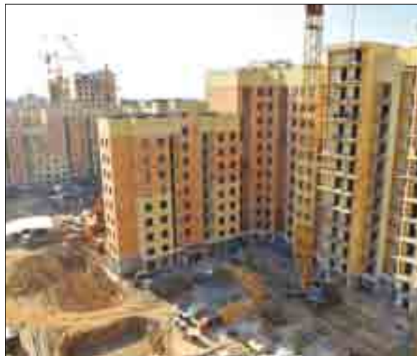
СТРОИТЕЛЬСТВО ИДЕТ ПОЛНЫМ ХОДОМ
