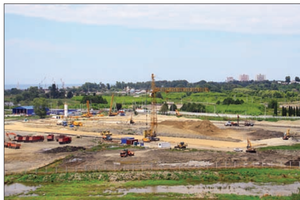
СТРОИТЕЛЬСТВО КРЫТОГО КОНЬКОБЕЖНОГО ЦЕНТРА
