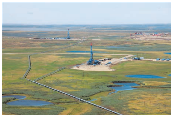
БУРОВАЯ ВЫШКА «ЕКАТЕРИНА» НА БОВАНЕНКОВСКОМ МЕСТОРОЖДЕНИИ
