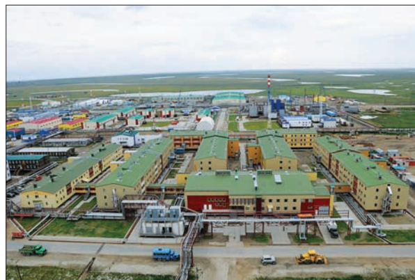
БОВАНЕНКОВО. ВАХТОВЫЙ ЖИЛОЙ КОМПЛЕКС
