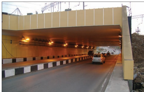
ГОТОВЫЙ ТОННель НА ПЕРЕСЕЧЕНИИ ВАРШАВСКОГО ШОССЕ С ЖЕЛЕЗНОДОРОЖНЫМИ ПУТЯМИ КУРСКОГО НАПРАВЛЕНИЯ МЖД
