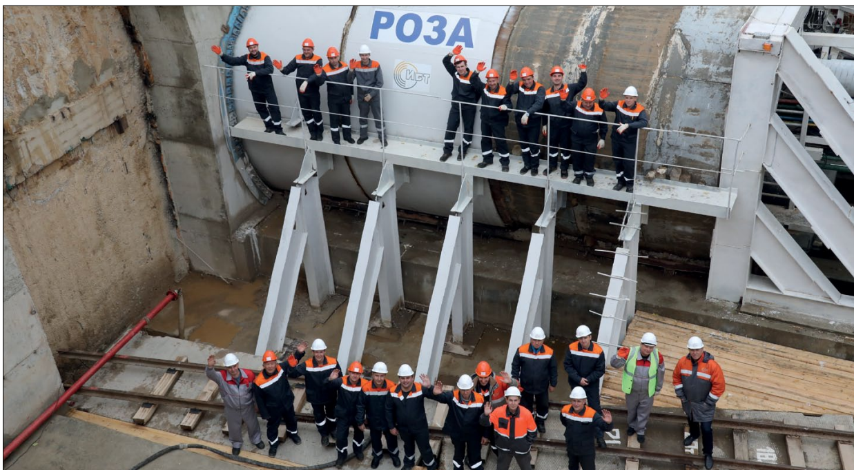
Южный участок Большой кольцевой линии, монтажно-щитовая камера за действующей станцией метро «Каховская»
