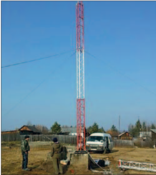
ЛИКВИДАЦИЯ ЦИФРОВОГО НЕРАВЕНСТВА. МОНТАЖ РАДИО-МАЧТЫ В ПОС. УСТЬ-УРКИМА ТЫНДИНСКОГО РАЙОНА
