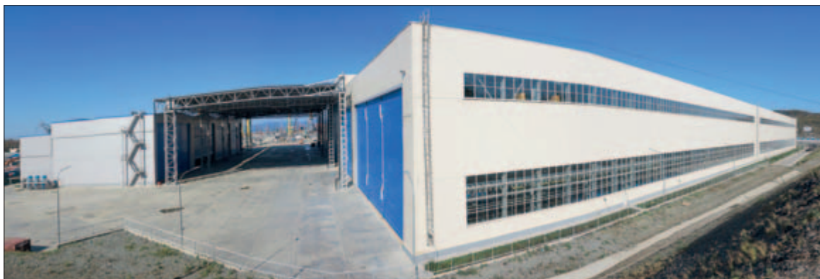
БЛОК КОРПУСНЫХ ПРОИЗВОДСТВ И ОКРАСОЧНЫЕ КАМЕРЫ
