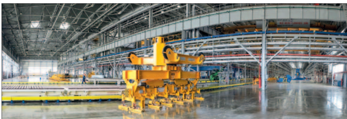
БЛОК КОРПУСНЫХ ПРОИЗВОДСТВ
