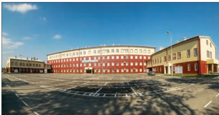
ВОЕННЫЙ ГОРОДОК ВДВ. КОМПЛЕКСНОЕ ЗДАНИЕ. СТАНЦИЯ РАЕВСКАЯ, КРАСНОДАРСКИЙ КРАЙ
