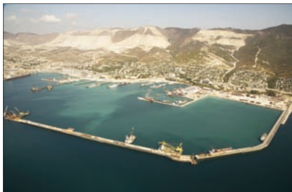
СТРОИТЕЛЬСТВО ВОЕННОЙ ГАВАНИ. ВИД С ВЕРТОЛЕТА. НОВОРОССИЙСК, КРАСНОДАРСКИЙ КРАЙ
