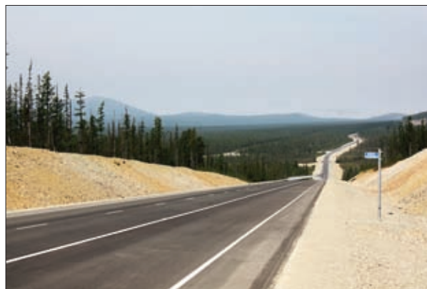
КМ 579 АВТОДОРОГИ «ЛЕНА» ПОСЛЕ РЕКОНСТРУКЦИИ
