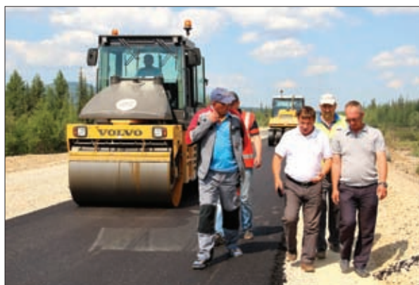
КАПИТАЛЬНЫЙ РЕМОНТ КМ 609 – КМ 617 АВТОДОРОГИ «ЛЕНА»
