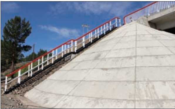
МОСТ ЧЕРЕЗ Р. ТУРУ, БЕРЕГОВАЯ ОПОРА
