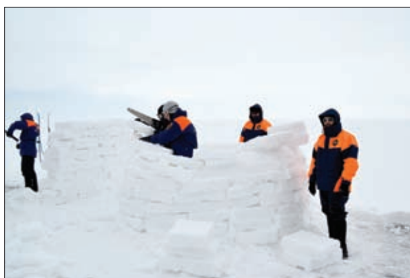
СТРОИТЕЛЬСТВО ИГЛУ – ВРЕМЕННОГО ЖИЛИЩА ИЗ СНЕГА И ЛЬДА
