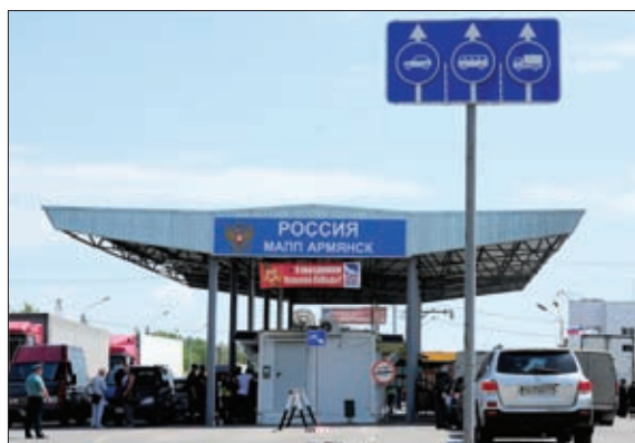
МНОГОСТОРОННИЙ АВТОМОБИЛЬНЫЙ ПУНКТ ПРОПУСКА (МАПП) «АРМЯНСК», КРЫМ
