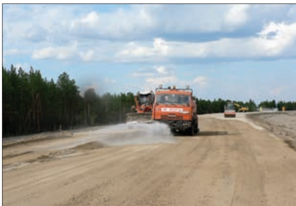
ОБЕСПЫЛИВАНИЕ УЧАСТКА СТРОИТЕЛЬСТВА АВТОДОРОГИ «ВИЛЮЙ» 582–592-Й КМ (СДАН В 2014 ГОДУ)
