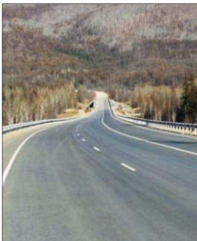
ФЕДЕРАЛЬНАЯ АВТОМОБИЛЬНАЯ ДОРОГА М-56 (А-360) ПОСЛЕ РЕКОНСТРУКЦИИ (УЧАСТОК КМ 58 – КМ 63)
