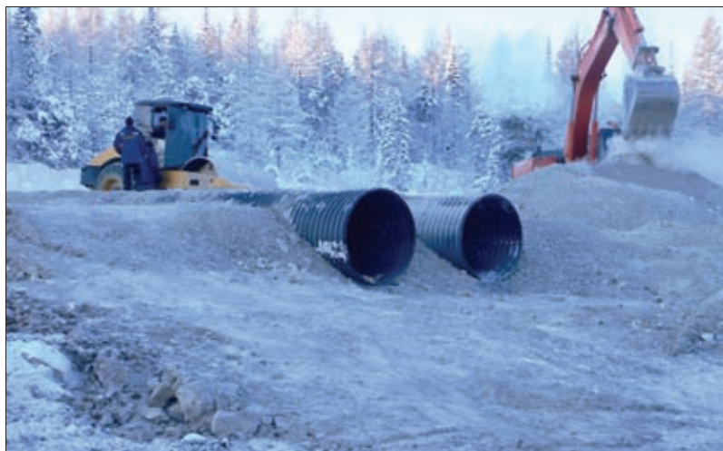
КАПИТАЛЬНЫЙ РЕМОТ АВТОДОРОГИ (УЧАСТОК КМ 621 – КМ 627)
