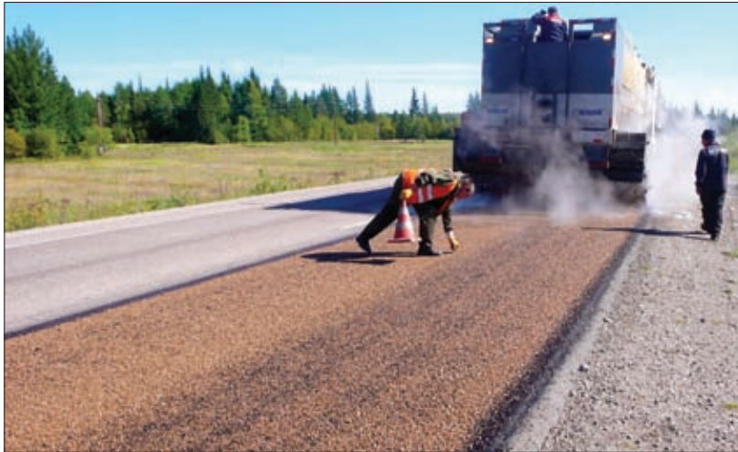
РАБОТНИКИ ООО «МЕГАСТРОЙ» ВЫПОЛНЯЮТ РАБОТЫ ПО УСТРОЙСТВУ ШЕРОХОВОЙ ПОВЕРХНОСТНОЙ ОБРАБОТКИ ДОРОЖНОГО ПОЛОТНА С ПРИМЕНЕНИЕМ БИТУМНОЙ ЭМУЛЬСИИ В КАЧЕСТВЕ ВЯЖУЩЕГО МАТЕРИАЛА
