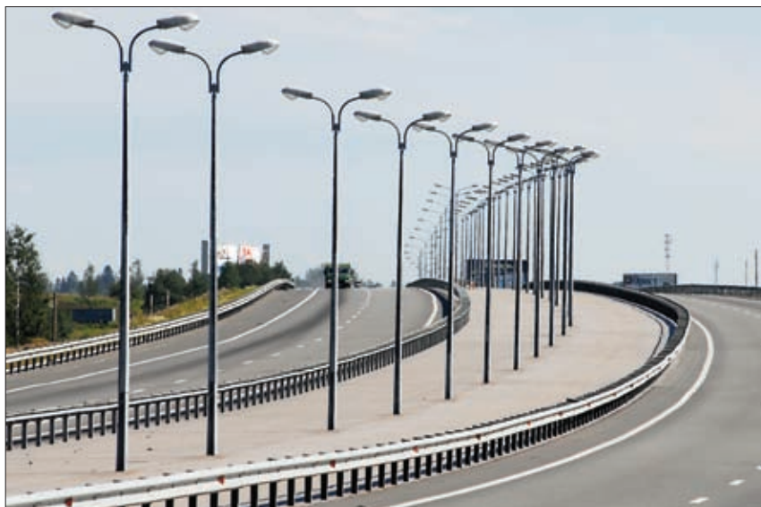
КОЛЬЦЕВАЯ АВТОДОРОГА САНКТ-ПЕТЕРБУРГА
