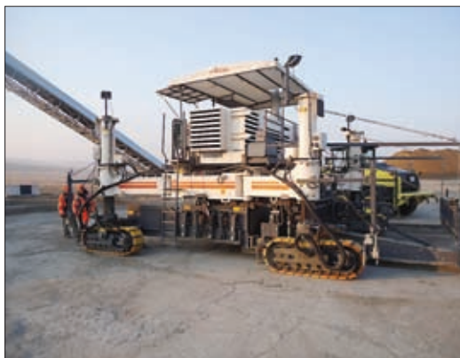
БЕТОНУКЛАДЧИК WIRTGEN SP850 НА ГУСЕНИЧНОМ ХОДУ СО СКОльзящей ОПАЛУБКой
