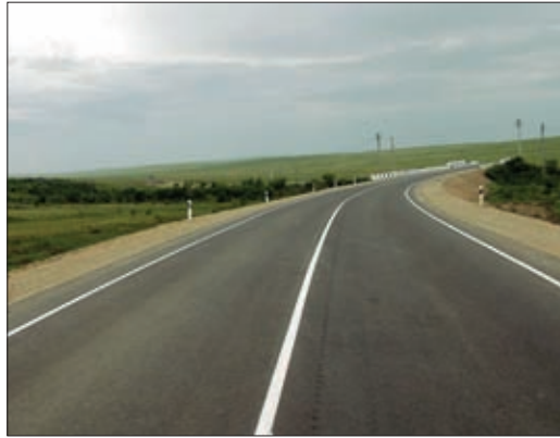
ОТРЕМОНТИРОВАННЫЙ УЧАСТОК АВТОДОРОГИ ЧИТА – ЗАБАЙКАЛЬСК
