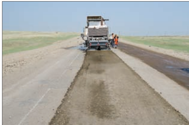
УСТРОЙСТВО СЛОЯ ИЗ ОРГАНО-МИНЕРАЛЬНОЙ СМЕСИ РЕСАЙКЛЕРОМ WIRTGEN 2200CR ООО «СТРОЙСЕРВИС»
