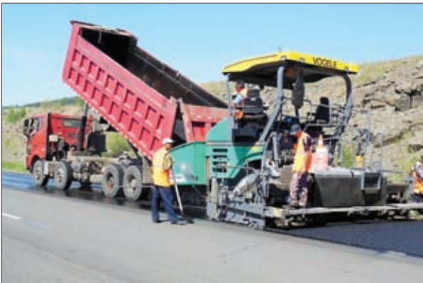
УСТРОЙСТВО ЗАЩИТНЫХ СЛОЕВ ИЗ ОТКРЫТОЙ БИТУМОМИНЕРАЛЬНОЙ СМЕСИ РАБОТНИКАМИ ООО «ЗАБДОРСТРОЙ»
