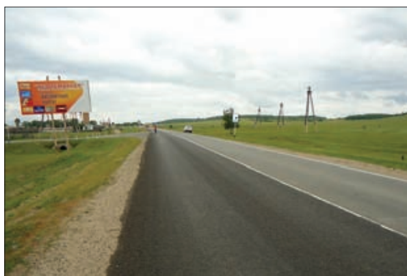
ЗАЩИТНЫЙ СЛОЙ, УСТРОЕННЫЙ ООО «МЕГАСТРОЙ» МЕТОДОМ MICROSURFACING
