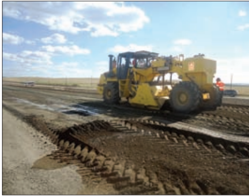
УСТРОЙСТВО СЛОЯ ИЗ АСФАЛЬТОГРАНУЛОБЕТОНА МЕТОДОМ ХОЛОДНОГО РЕСАЙКЛИНГА РЕГЕНЕРАТОРОМ-СМЕСИТЕЛЕМ CATERPILLAR RM-500
