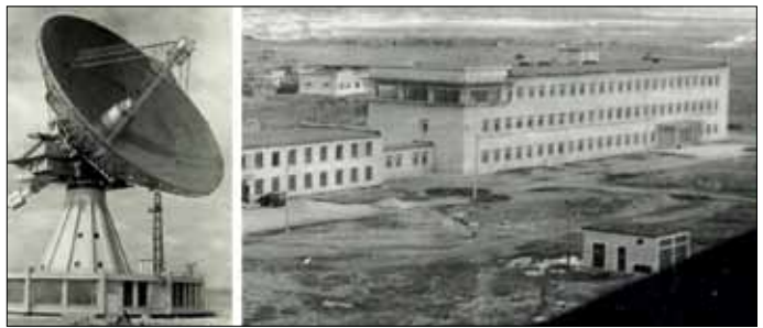
НАЗЕМНЫЙ РАДИОТЕХНИЧЕСКИЙ КОМПЛЕКС «САТУРН-МСД» В ВОСТОЧНОМ ЦЕНТРЕ ДАЛЬНОЙ КОСМИЧЕСКОЙ СВЯЗИ В УССУРИЙСКЕ. АНТЕННА П400
